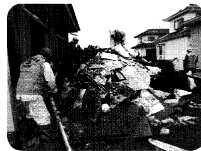
←ガレキ撤去作業
