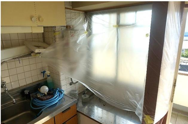
③ 窓 に も 養 生 を し ま す 。 養 生 と 下 地 処 理 に し っ か り 時 間 を 使 い ま す 。
